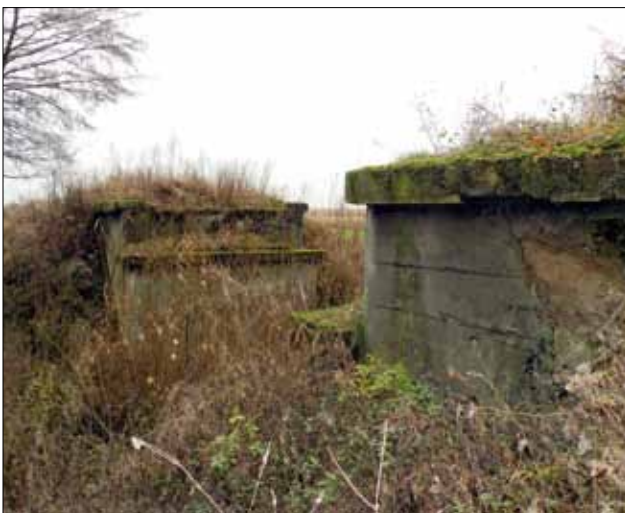
Betonowe przyczółki mostu na Olszynie w roku 2009. Fot. autor.
